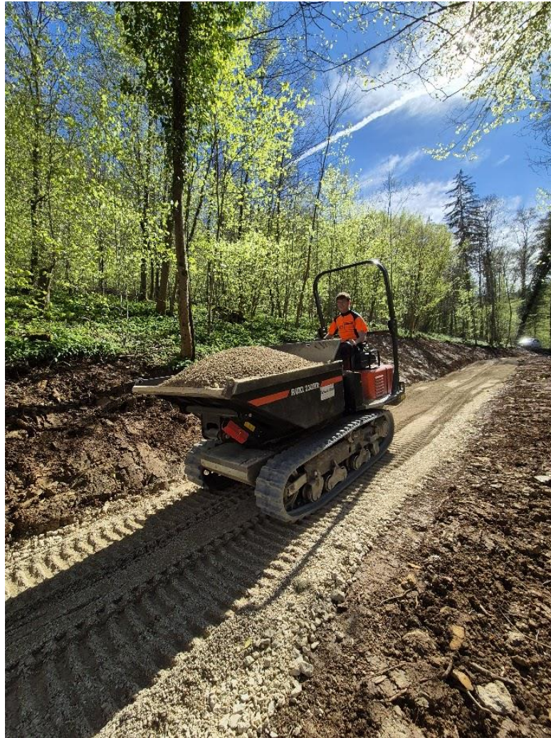
In Bad Zurzach wurde ein neuer Weg zum Tierpark durch das Forstteam gebaut.
